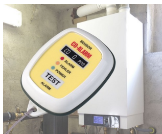
Appareil d'alarme de gaz CO
